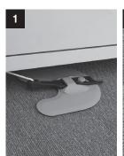
取り付け部分(2箇所)の汚れ、ほ こり、水分、油分をよく拭きとり、 予め設置位置を決定しておきま す。(高強度ロープが少したるむ 程度の位置)
